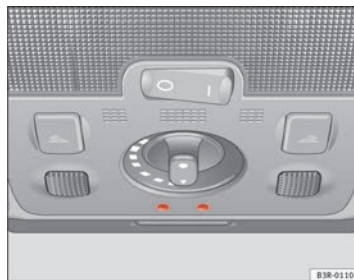
Fig. 95 Detalle del revestimiento del techo: Iluminación ambiental
